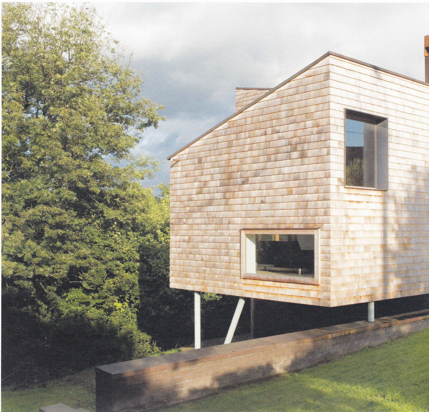
Esneux (Montfort), Maison privée - Private house M me Malmedy, 2007. Arch.: DMN Architecture
